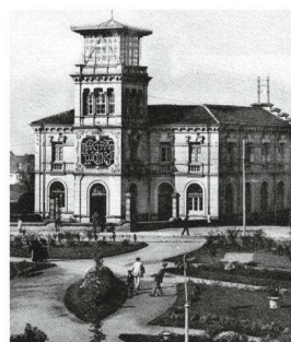
Edificio de Barras Eléctricas (Lugo)
